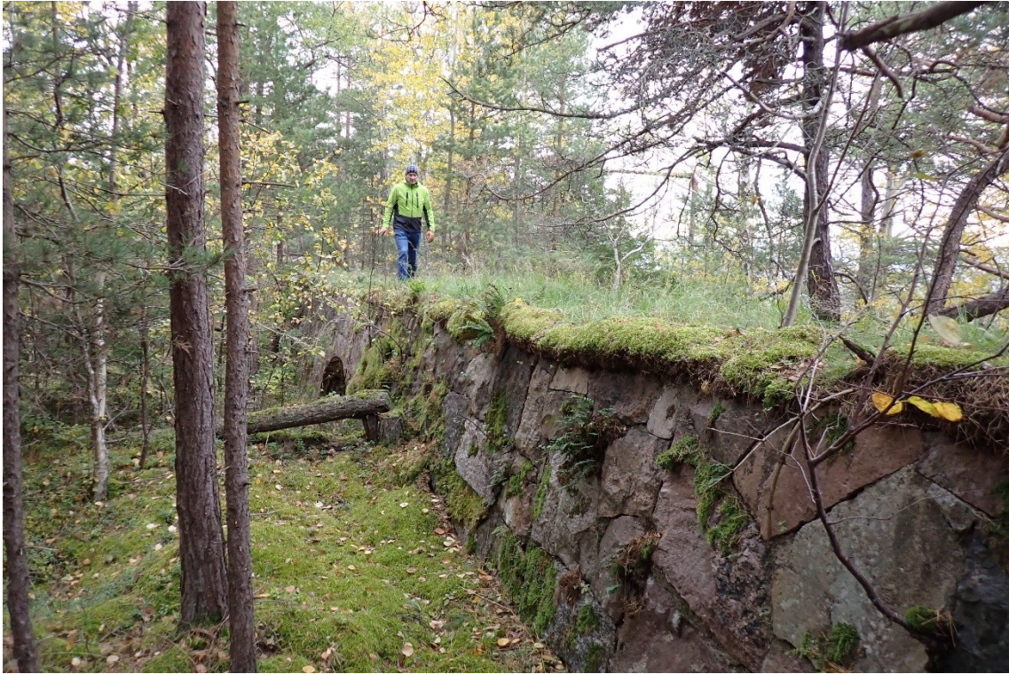
Kuva 36. Arvokas valoheitinrata on kasvillisuuden peitossa ja osin myös puut kasvavat kivien välissä, sen juurella tai jopa rakennelman päällä.
